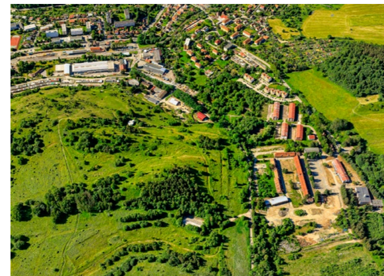
Brownfield bývalých kasáren Vyšný v Českém Krumlově
