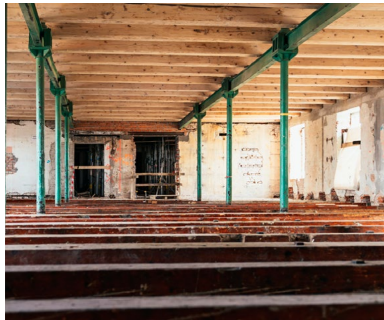
Interiér Automatických mlýnů před rekonstrukcí na Gočárovu galerii
