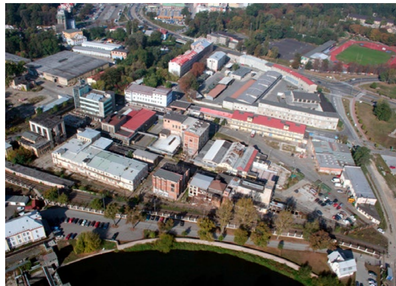
Celkový pohled na původní areál Milu před demolicí
