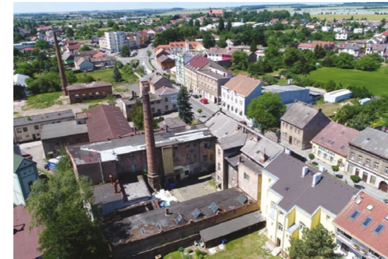
Cihlovka 1 a 2 před rekonstrukcí a výstavbou
