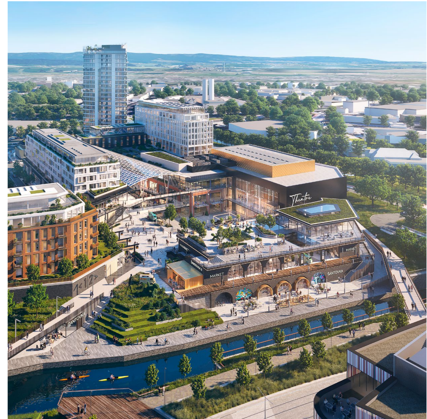
Připravovaná dostavba Šantovka District na druhém břehu Mlýnského potoka
