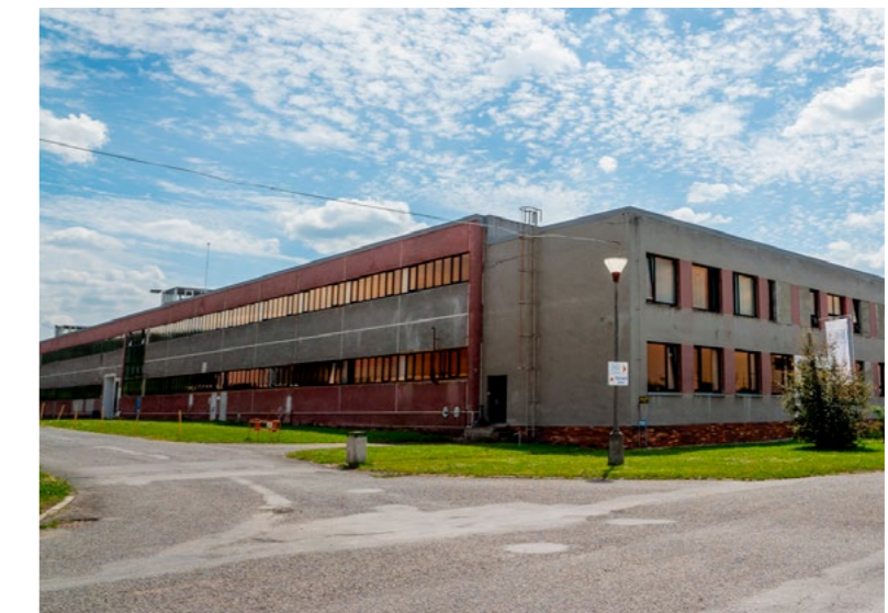
Budova Beta z roku 1967 před rekonstrukcí
