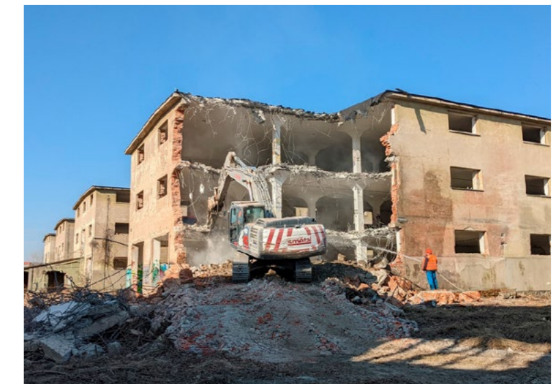
Demolice brownfieldu po Vojenském opravárenském podniku
