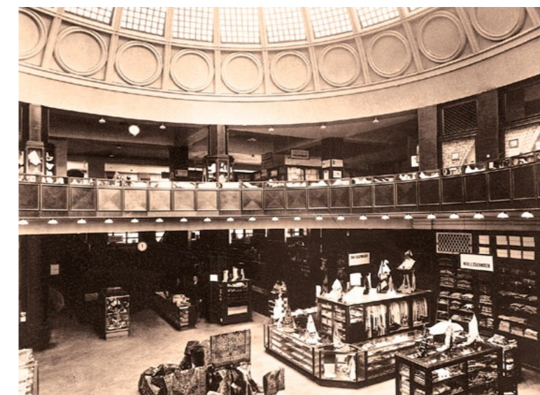
Historická fotografie interiéru obchodního domu Breda & Weinstein
